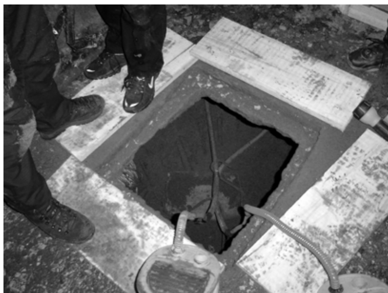
Entrada do túnel escavado.
